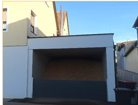
Zubau Hackgutheizung Gemeindeamt und Volksschule Weiden bei Rechnitz
